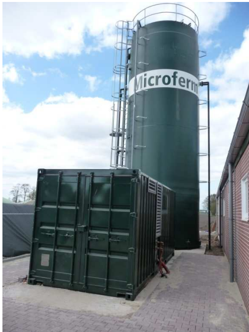
Vergister en WKK/besturingscontainer
