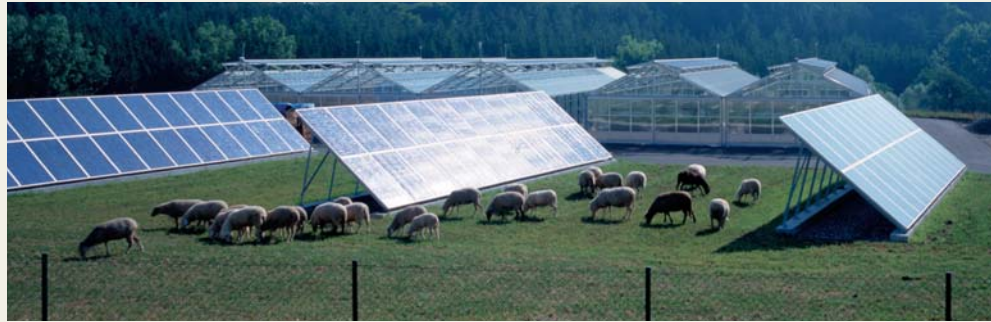
Solare Klärschlamm-trocknung Balingen
