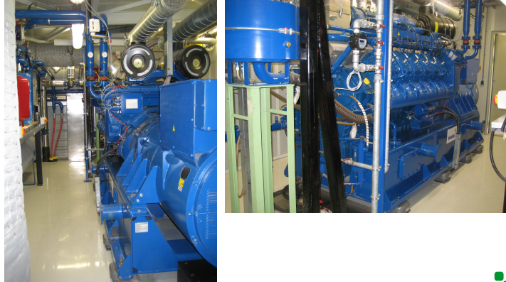
Biogas TCG 2020 V12 (1.200 kWe) akoestische buitenomkasting
