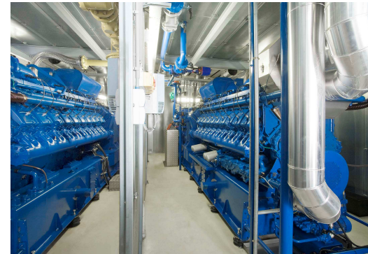
Biogas 2 x TCG 2020 V20 (2.000 kWe) akoestische binnenomkasting
