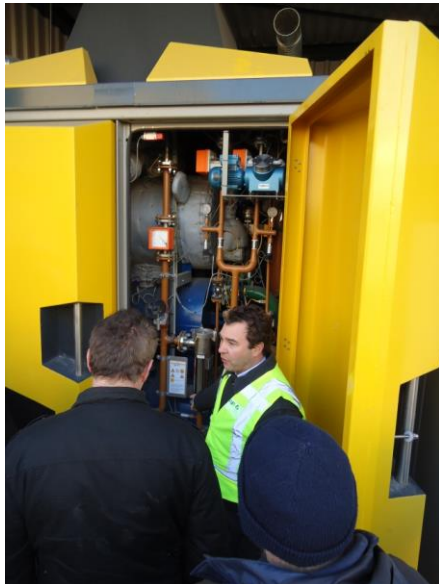
Triegen ORC produceert elektriciteit uit restwarmte
