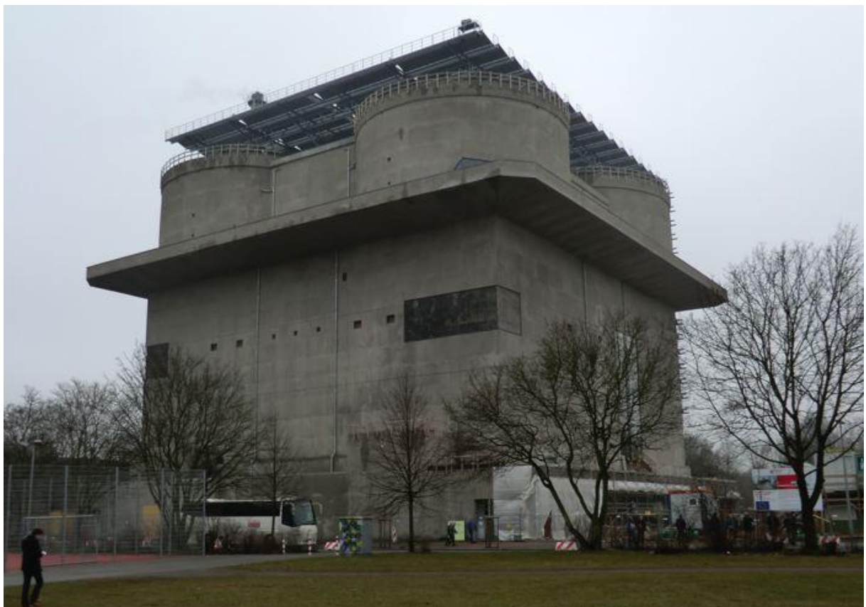
De Energiebunker van de wijk Wilhelmsburg met op het dak de grootste zonnecollector met vacuümbuizen in Duitsland
