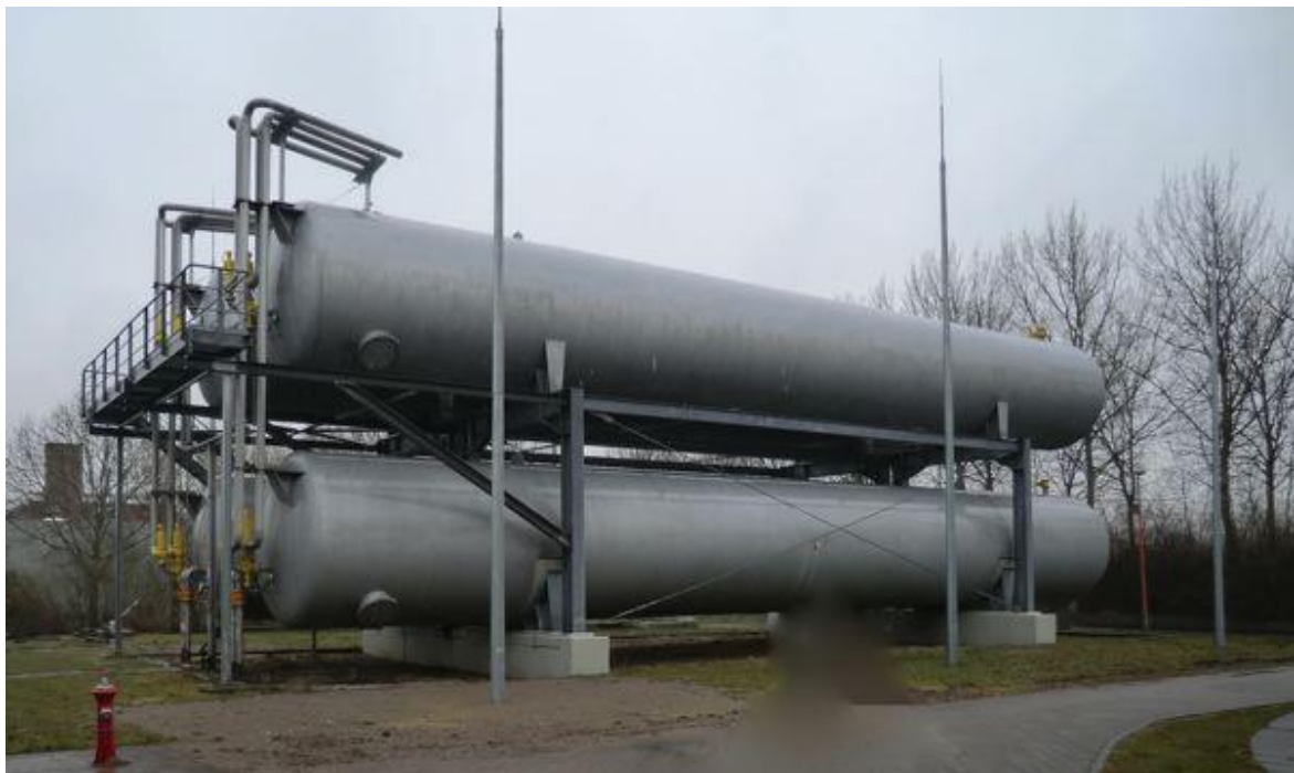
De opslagtanks voor biogas in Hetlingen
