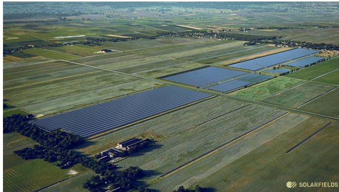
Zonnepark Hollandia Nieuw Buinen 120 MWp
