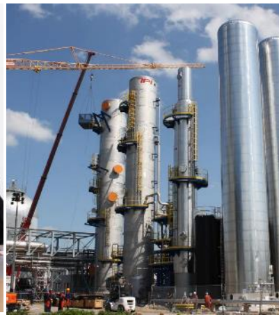
Bouw CO 2 afvangstinstallatie
